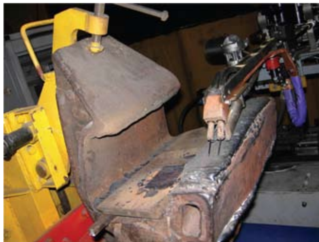
Рис.3 Установка для 2-х электродной наплавки порошковой проволокой с боковой подачей газа корпуса зуба автосцепного устройства ж/д вагона. Ширина наплавки – 60 мм. Толщина слоя 5 мм. Производительность установки – два корпуса в час. Сварочные материалы – порошковая проволока диаметром 1,6 мм марки ПП-АН180МН, защитный газ – CO 2 .
